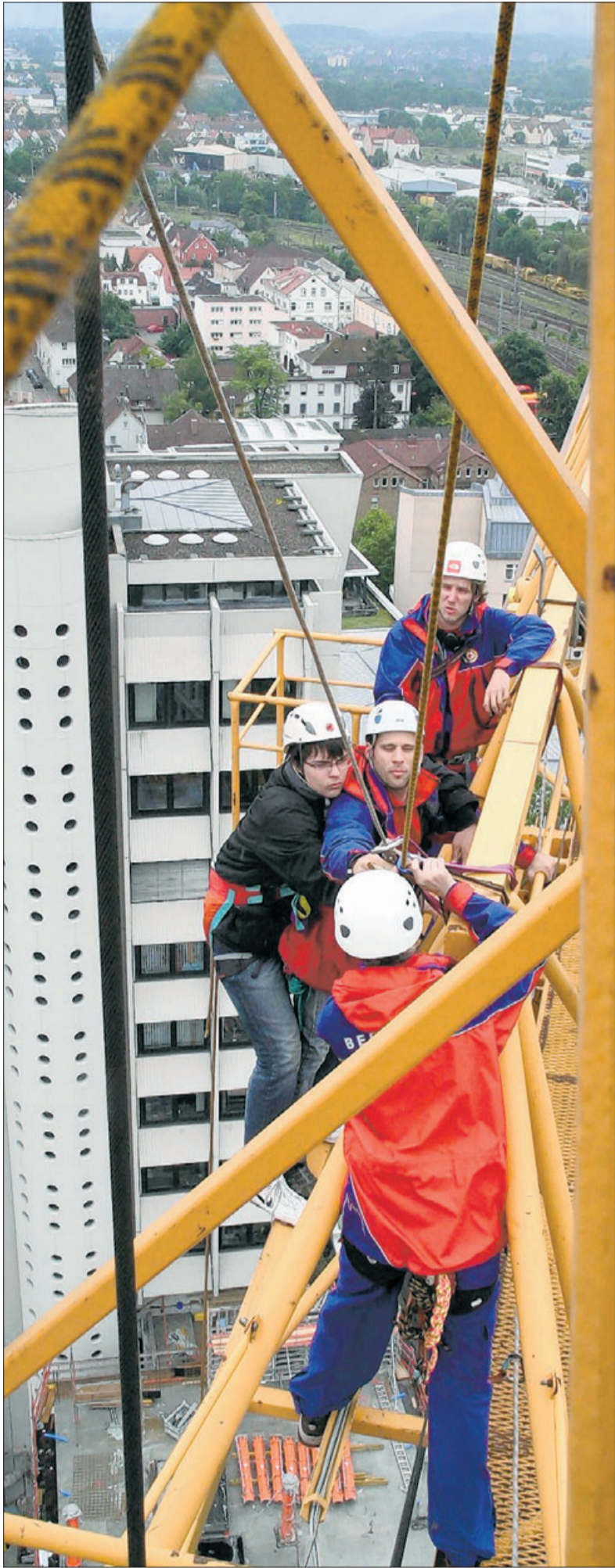
In über 60 Meter Höhe an einem Baukran an der Göppinger Kreissparkasse übte die Göppinger Bergwacht den Ernstfall. Foto: Privat
